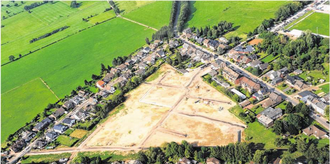
Jetzt können die Hausbauer loslegen im Breiniger Neubaugebiet zwischen Corneliastraße und Schützheide. Am Freitag wird die Fertigstellung der Erschließung gefeiert. Ein großer Teil der Grundstücke an Edi-Braun-, Gerd-Lützeler-, Adolf-Althoff- oder Inge-Stoll-Straße ist bereits vermarktet. Foto: Peter Flink
