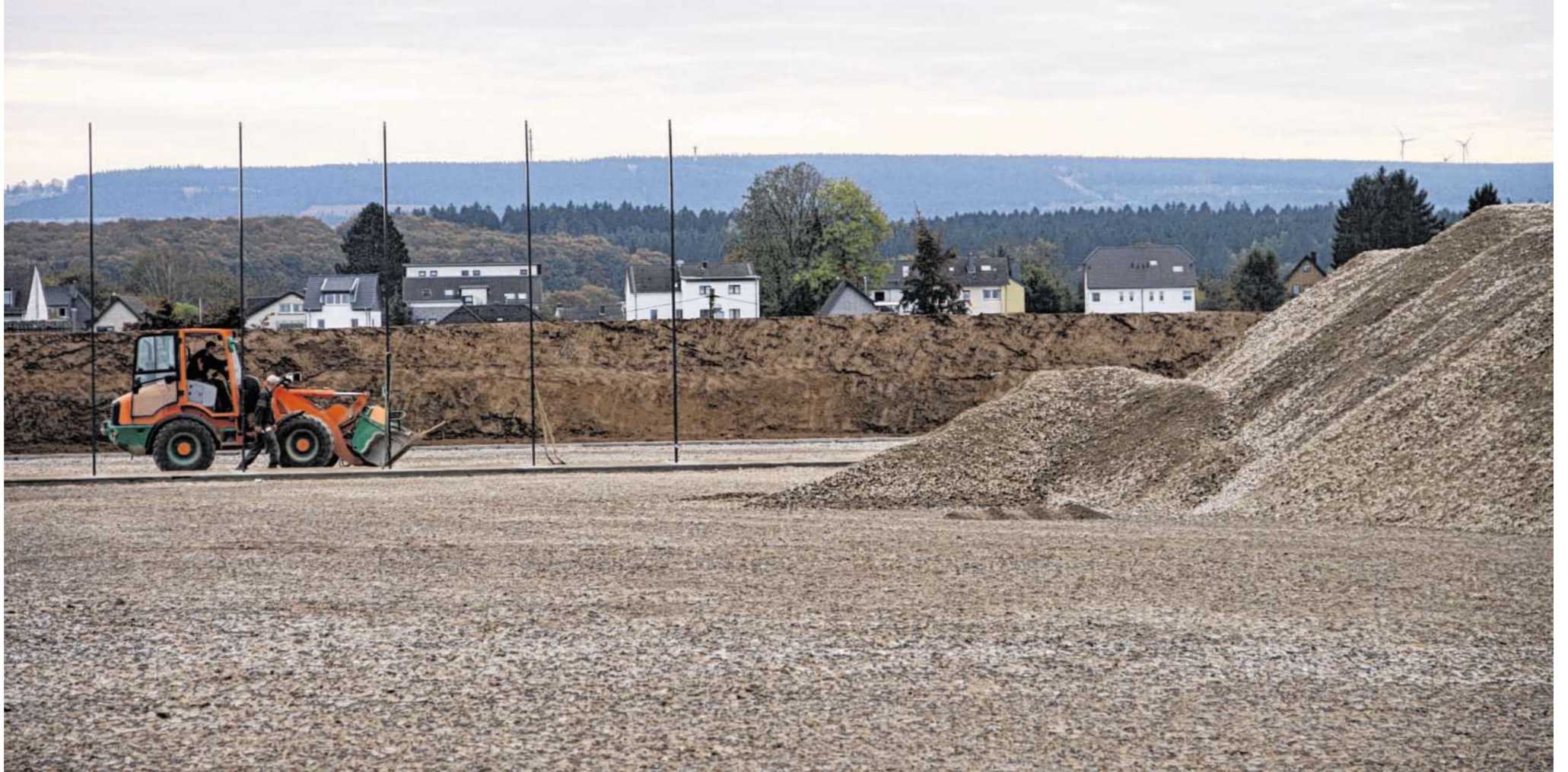
Unterbau und Versickerungsanlage für das neue Sportzentrum des SV Breinig sind bereits fertiggestellt. Als nächstes soll das Flutlicht kommen, dann der Kunstrasen. Foto: L. Franzen
