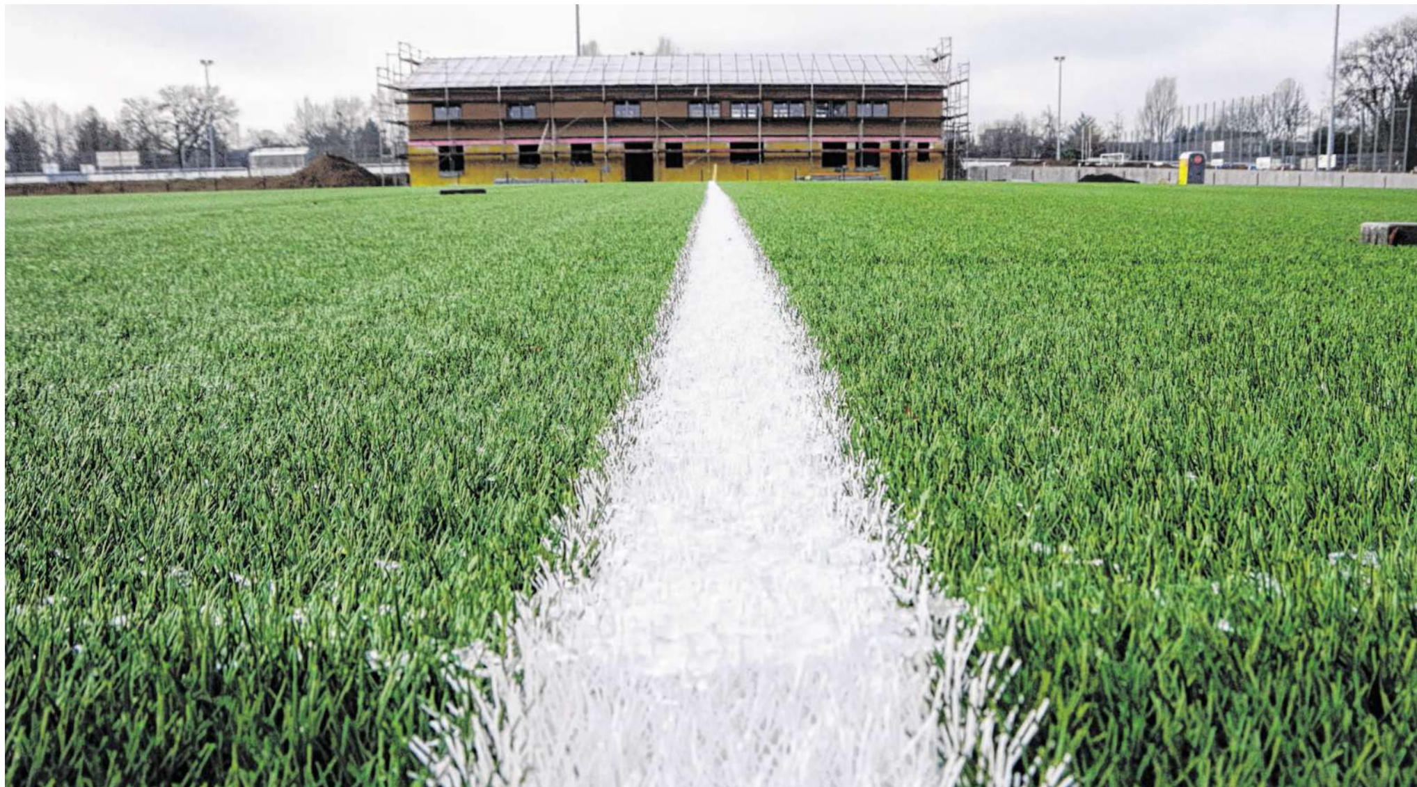
Bemerkenswerte Fortschritte verzeichnet der Spielverein bei der Realisierung des neuen Breiniger Sportparks. Das Kleinspielfeld ist fertig. Auf dem großen Platz ist der Kunstrasenbelag ausgerollt und zur Hälfte verklebt. Die Flutlichtmasten sind errichtet, und das neue Vereinsheim steht im Rohbau. Foto: J. Lange
